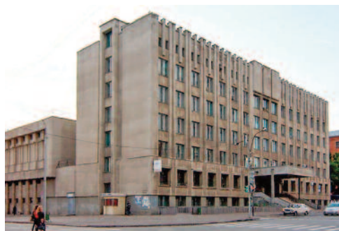
Институт «Казгражданпроект». Улица Достоевского, дом 35.
