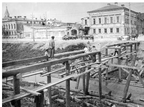
Ремонт моста через Булак. 1927 г.
