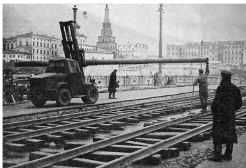
Установка столбов контактной сети на Ленинском мосту. 1956 г.
