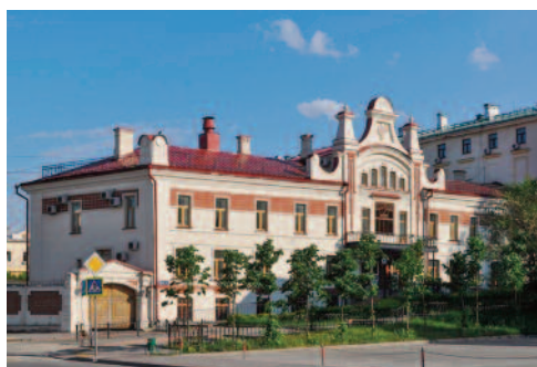
Здание Управления жилищной политики. Улица Миславского, дом 4.
