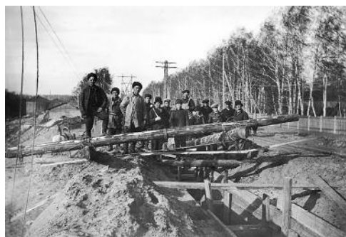
Прокладка первой кабельной канализации. 1920-е гг.
