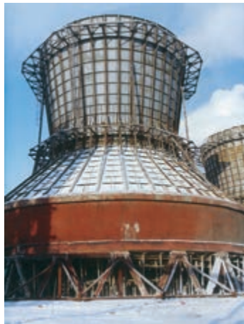
РФА КГҮнең Механика һәм машина төзелеше институты тарафыннан эшләнә торган терәк системасындагы СК-1200 градирясы. Түбән Кама ш.
