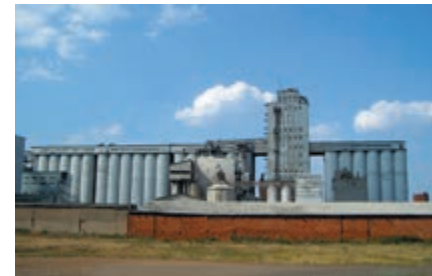
Чистопольский элеватор. Общий вид.
