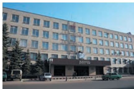
Чистопольский часовой завод «Восток». Административно-производственный корпус.
