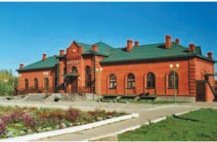
с.Шемордан. Здание железнодорожного вокзала.
