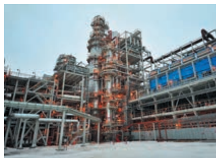
Установка ЭЛОУ-АВТ-7 АО «ТАНЕКО».
