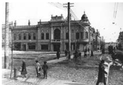
Ушковой дом в Казани. Архитектор К.Л.Мюфке. 1904–07. Фото нач. 20 в.
