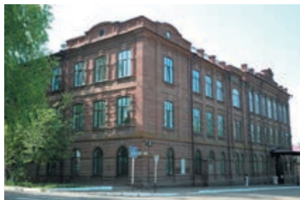
Первая мужская гимназия в г.Чистополь. Реконструкция С.В.Бечко-Друзина. 1908–09. Современный вид.
