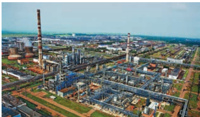
Нефтеперерабатывающий завод в г.Нижнекамск. Общий вид.
