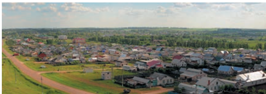
г.Тетюши. Новый микрорайон.
