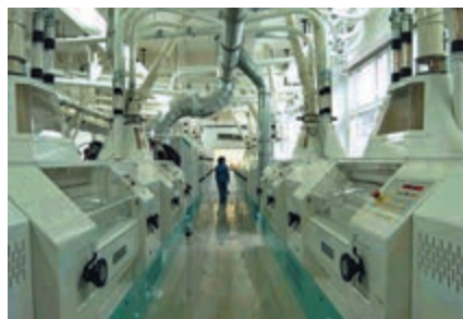
Мельница сортового помола АО «Челны-хлеб». г.Набережные Челны.
