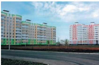
Новые крупнопанельные дома. г.Нижнекамск.
