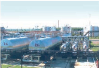
НГДУ «Нурлатнефть». Технологическая площадка установки подготовки высокосернистой нефти «Андреевка».
