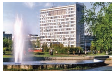
Здание Полиграфического комбината «Идел-Пресс».
