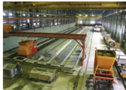
Производство пустотного настила АО «Кулонстрой».
