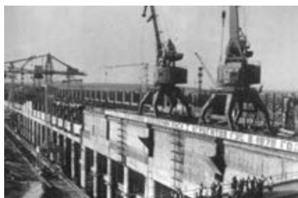
Строительство Нижнекамской ГЭС. 1970-е гг.
