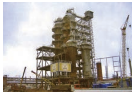
Возведение завода автобензинов в г. Нижнекамск. 2003.
