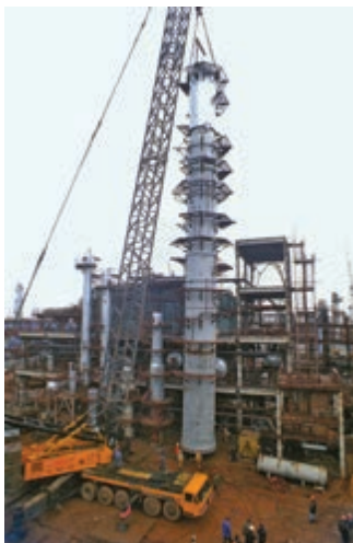
Монтажные работы на строительстве Нижнекамского нефтеперерабатывающего завода. 2001.
