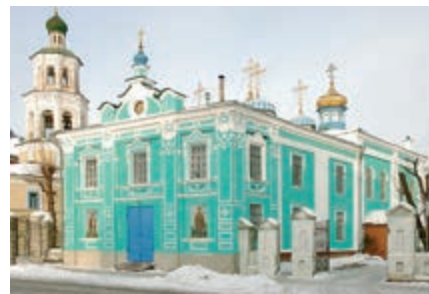
Никола-Низская церковь. Архитектор П.И.Романов. 1885.
