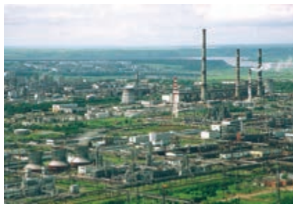
Нижнекамская ТЭЦ. Общий вид.
