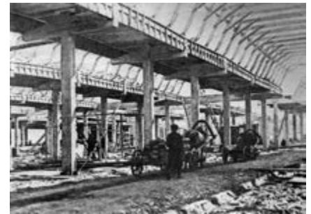
На строительстве моторостроительного завода. 1930-е гг.
