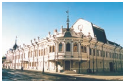
Здание Казан. театра юного зрителя (после реконструкции 1995–2001).
