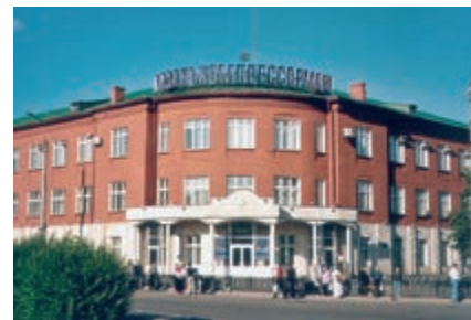
Казан. завод компрессорного машиностроения. Административный корпус.
