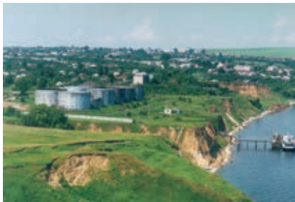
пгт Камское Устье. Общий вид с горы Лобач.
