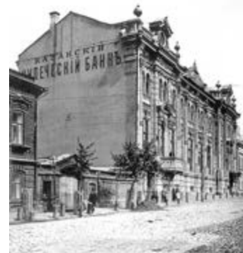
Здание купеческого банка. Около 1908. Фотограф Частихин.
