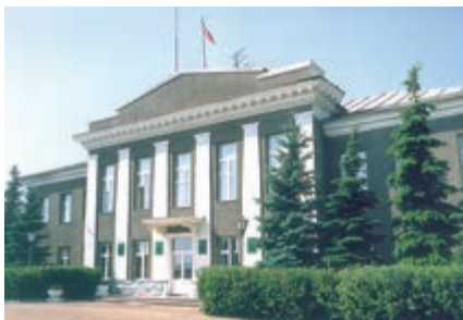
Здание районной администрации.
