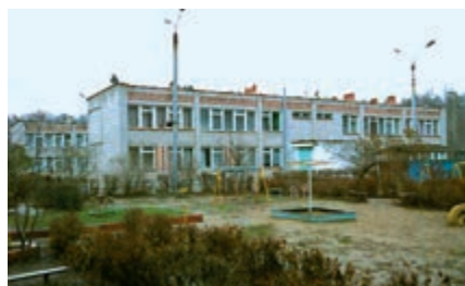
Санаторий «Берёзовая роща». Гл. корпус.
