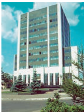
Г.А. Бакулин. Банк «Заречье». Казань. Реконструкция. 1996.
