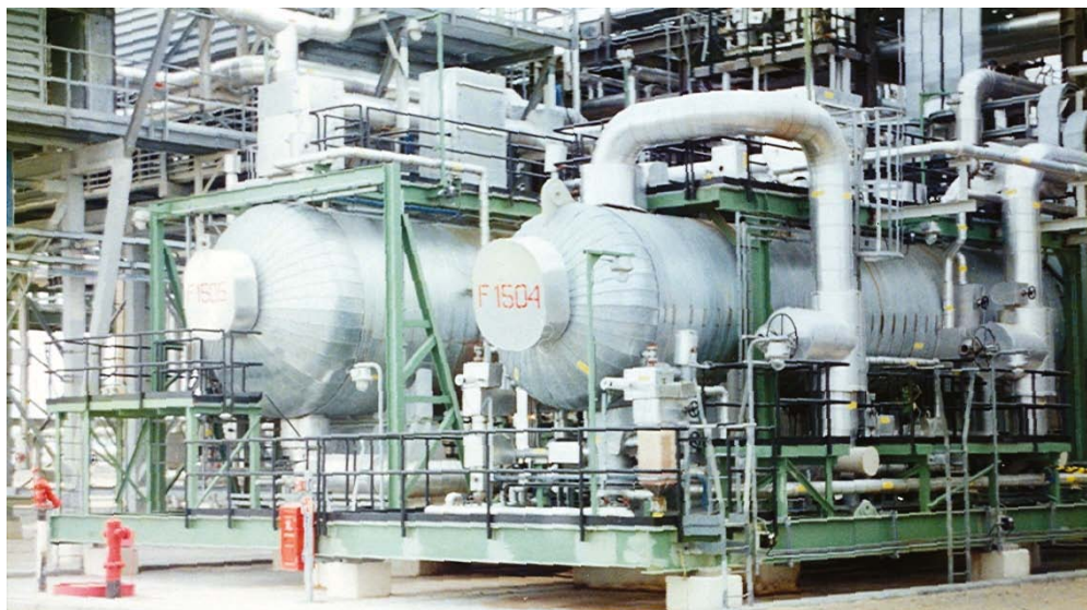
Ввод в эксплуатацию установок ДМС-1 по демеркаптанзации сырой нефти в Казахстане для СП «Тенгизшевройл». 1995–1996 гг.
