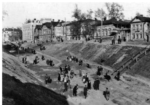
Улица Бутлерова. Работы по сглаживанию склона горы. 1953 г.
