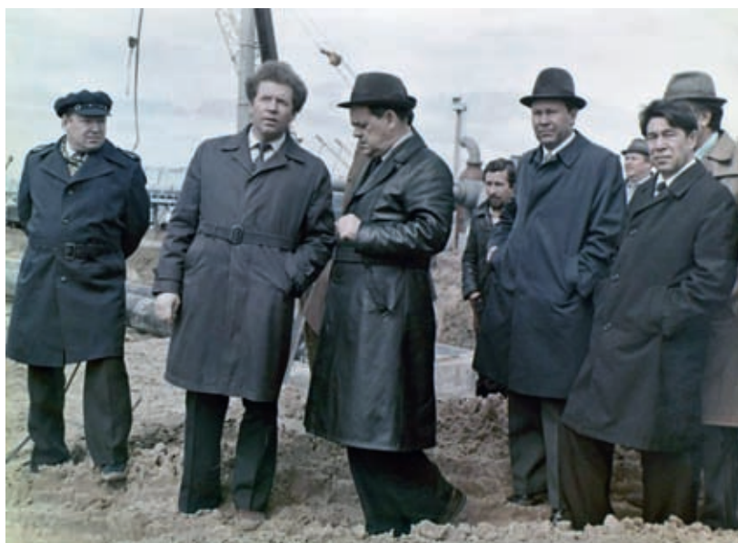
М.Г.Сабиров (крайний слева) и первый секретарь Татарского обкома КПСС Г.И.Усманов (четвертый слева) на строительстве компрессорной станции «Помарская» магистрального газопровода Уренгой – Помары – Ужгород в с. Помары Марийской АССР. 1980 г.
