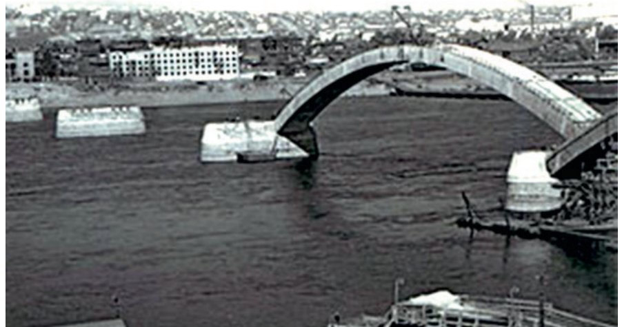
Строительство Коммунального моста через Енисей в Кызыле, начало 60-х годов
