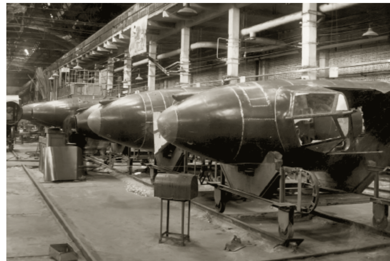
Пе-2 очкычы фюзеляжлары линиясе. 22 нче завод. 1940 еллар
