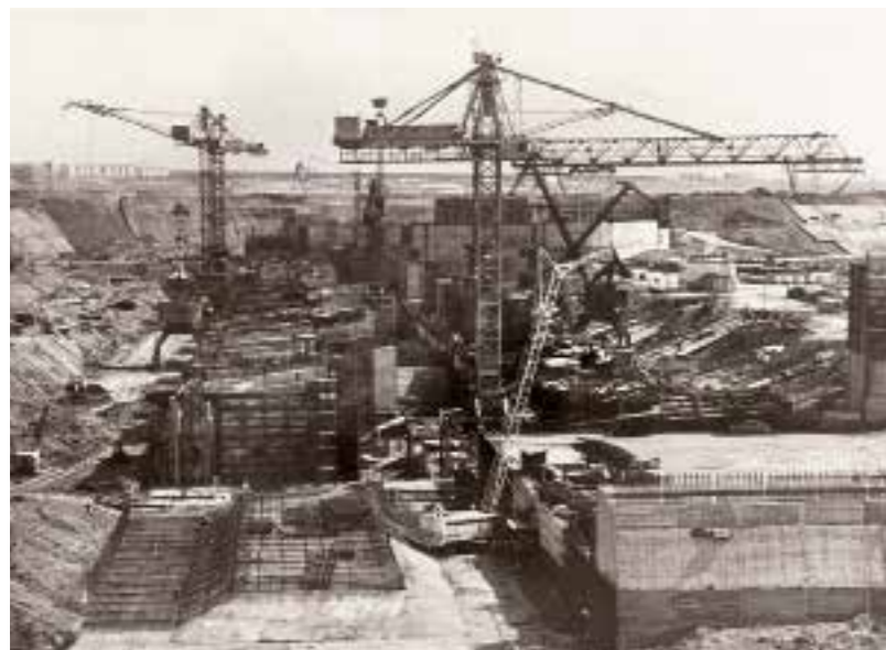
Түбән Кама гидроэлектростанциясе төзелеше. 1975 Строительство Нижнекамской гидроэлектростанции. 1975 Construction of the Nizhnekamsk hydro power plant. 1975
